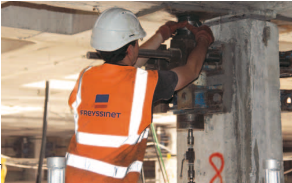
Les vérins, positionnés en tête des poteaux, ont permis de soulever de 50 cm la dalle de 2 000 t.
